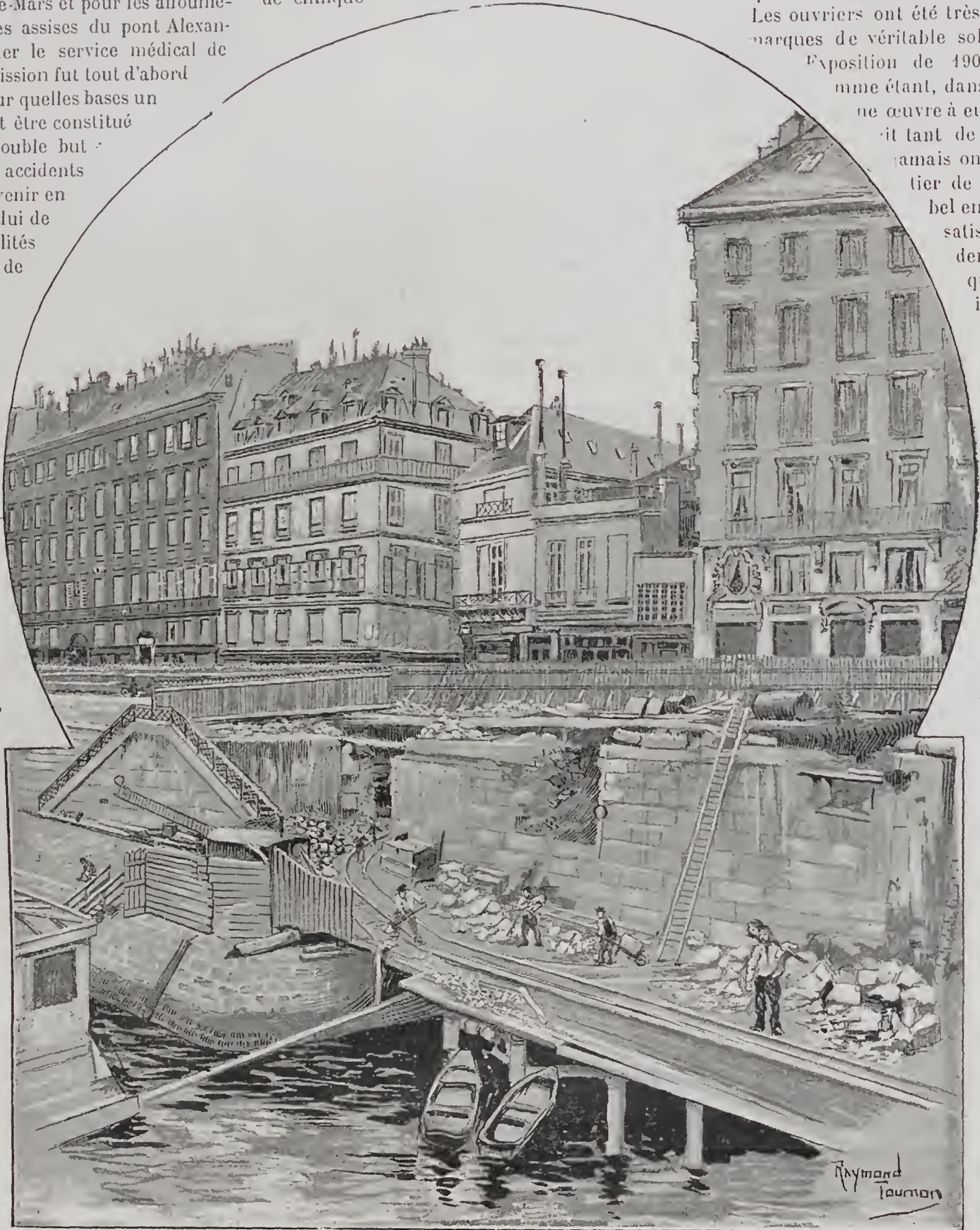
LES EMBARRAS DE PARIS. — Démolition et recul du mur de soutènement sur le quai Saint-Michel, pour le passage de la voie ferrée de l'Orléans.
